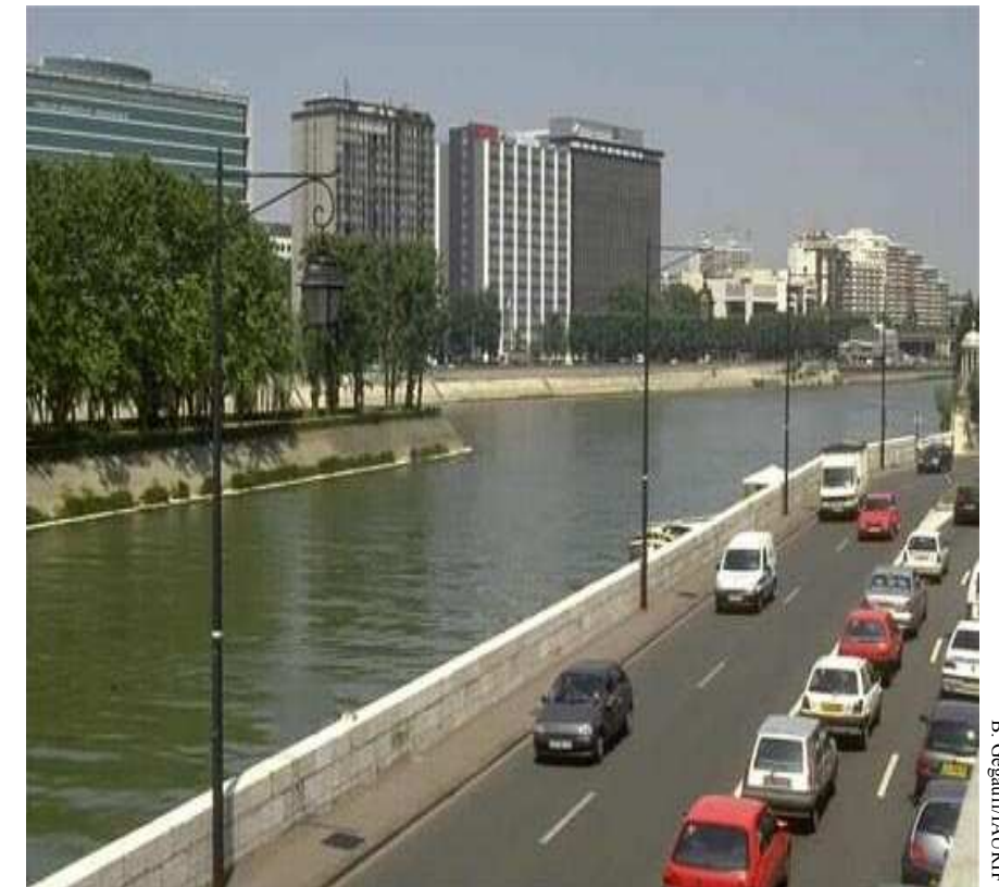
Voie Express Rive Droite dans les Hauts de Seine
